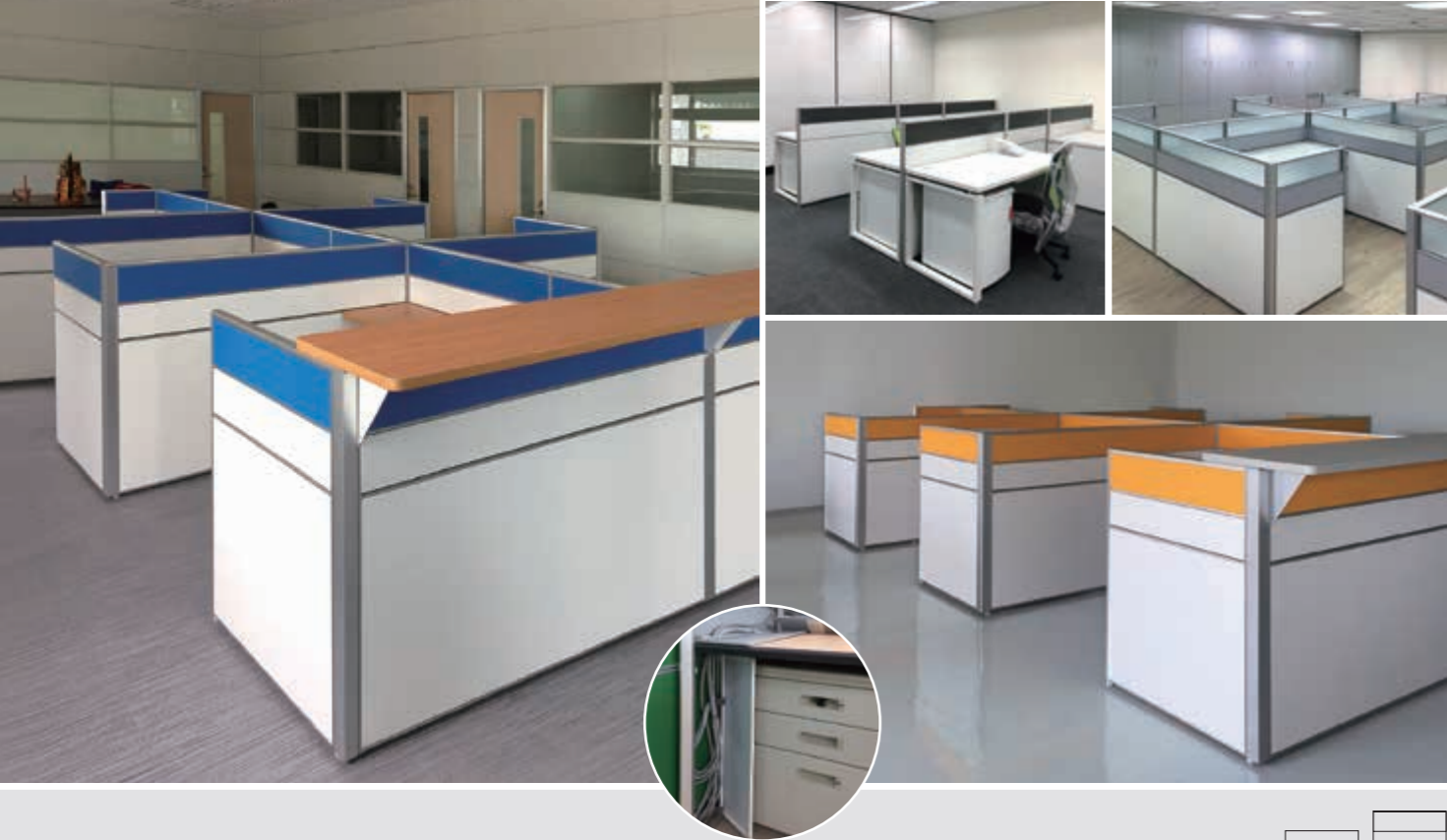
▲走線槽，線路完全隱藏不外露。
